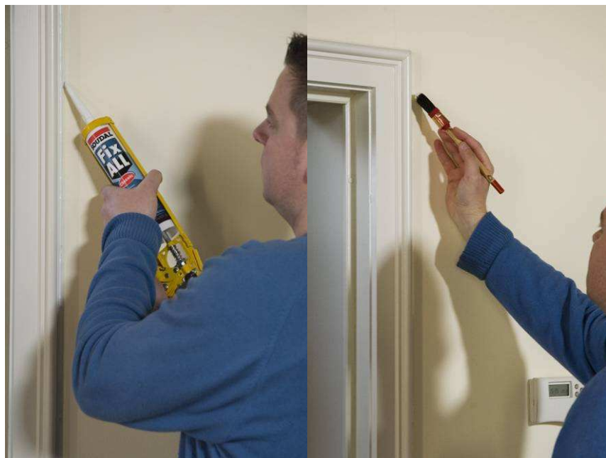
Швы, сделанные при помощи Soudal Fix All Classic, после отверждения можно красить, в том числе водными красками
